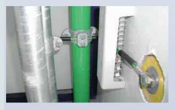
Equipotential busbars for protective and functional equipotential bonding and lightning equipotential bonding according to EN 62305-3
