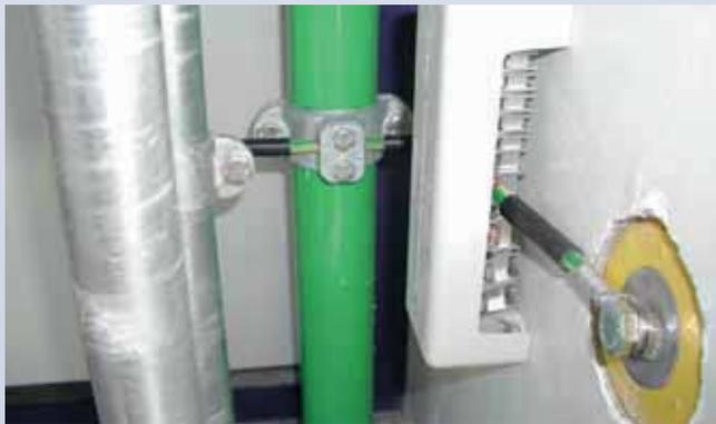
Equipotential busbars for protective and functional equipotential bonding and lightning equipotential bonding according to EN 62305-3
